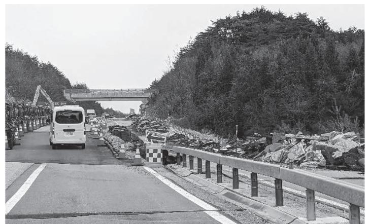
能登半島地震で道路の崩壊や陥没が多発し、復旧にも時間がかかっている
