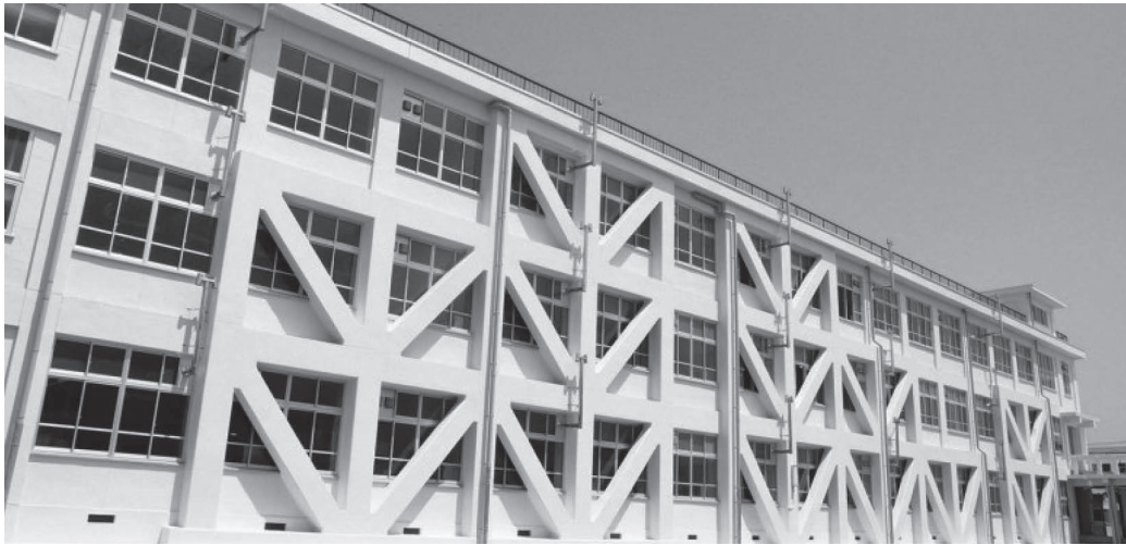
県立学校ですでに100%の耐震化できている。
