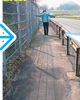
酒津の狭すぎる歩道で「電 動シニアカーが通れない」 の声。歩道拡幅が実現
